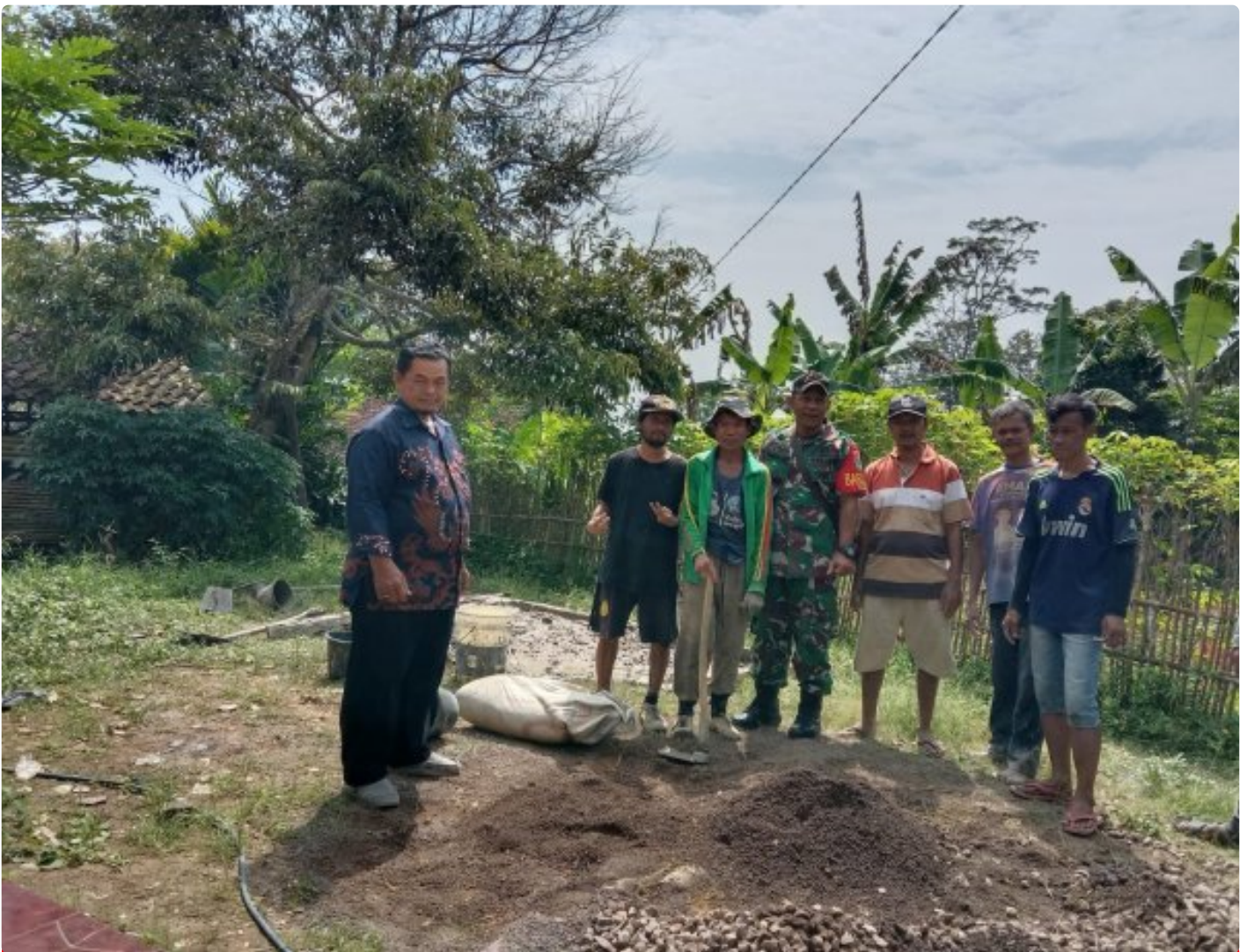
Serda Muhamad Monitoring Pembangunan Infrastruktur di Desa Tamansari Koramil 0622-04/Cikidang
