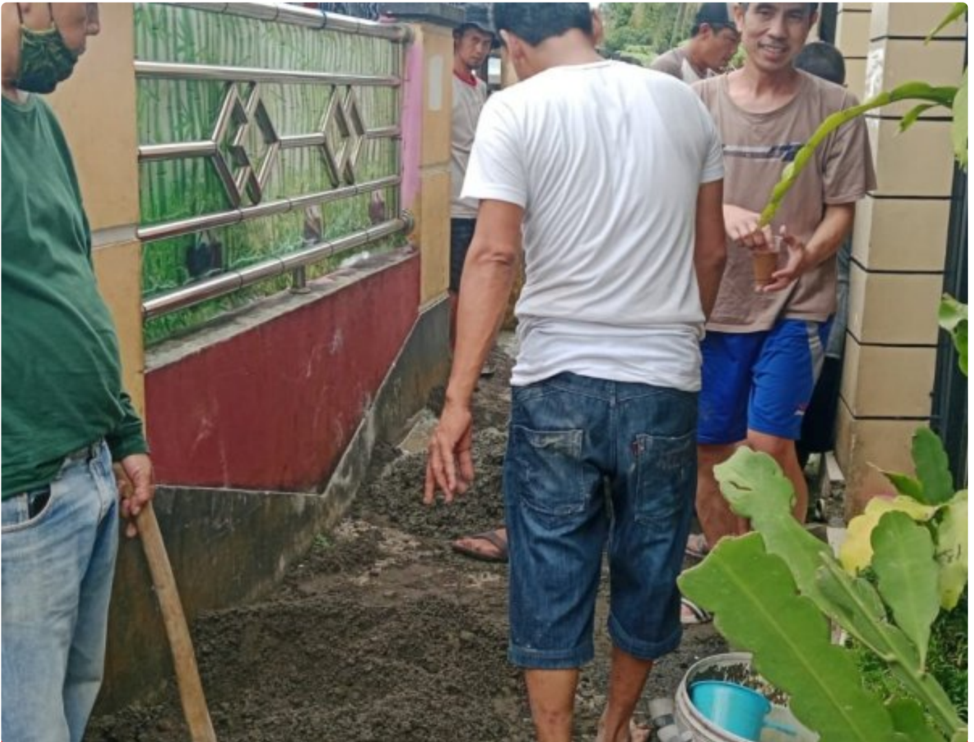
Jalan Gang Dibangun Secara Gotong di Sukabumi Jawa Barat
