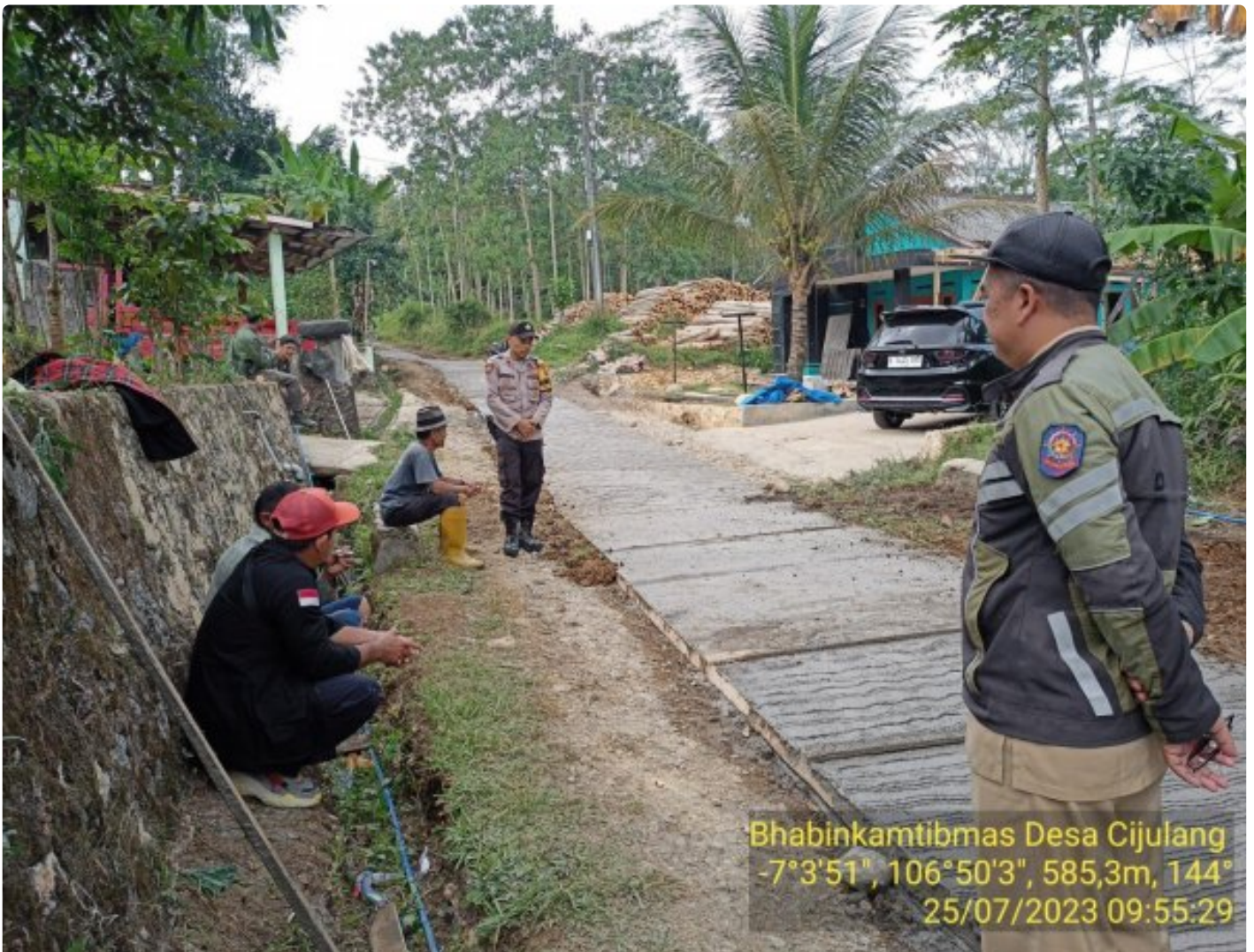
Aipda Sudiro Monitoring Pembangunan MCK di Desa
